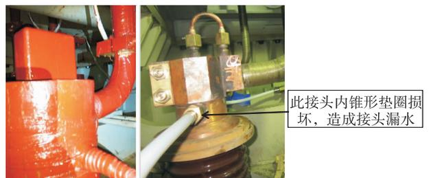
图 4 某 A 电厂绝缘筒处漏水
